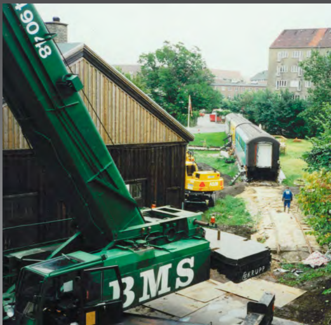
Skiftesporet sættes på nyanlagte jernbaneskiner 1993
